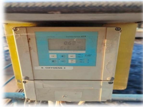
**Figure 11 :** l'oxymètre du bassin biologique (Source : ONA , 2023)
