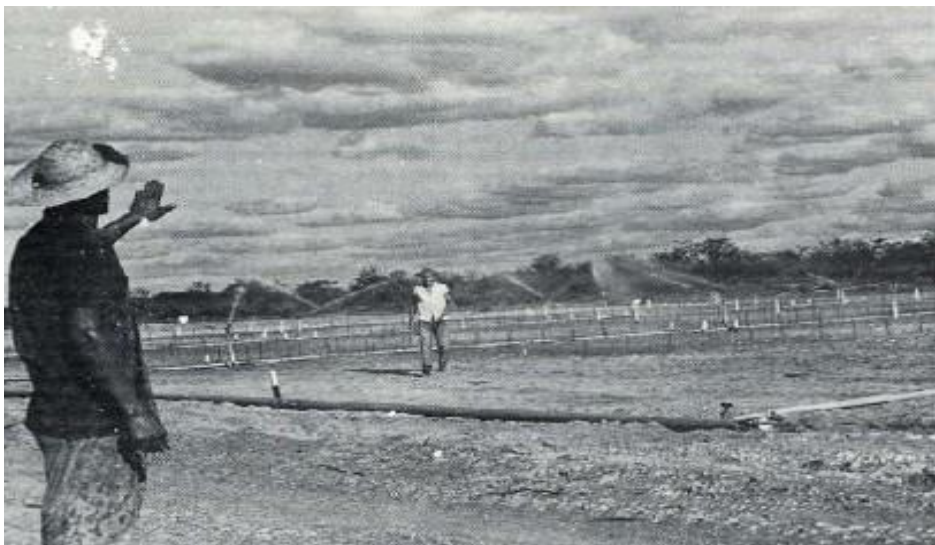
Figure 13. Réseau d'irrigation par aspersion
