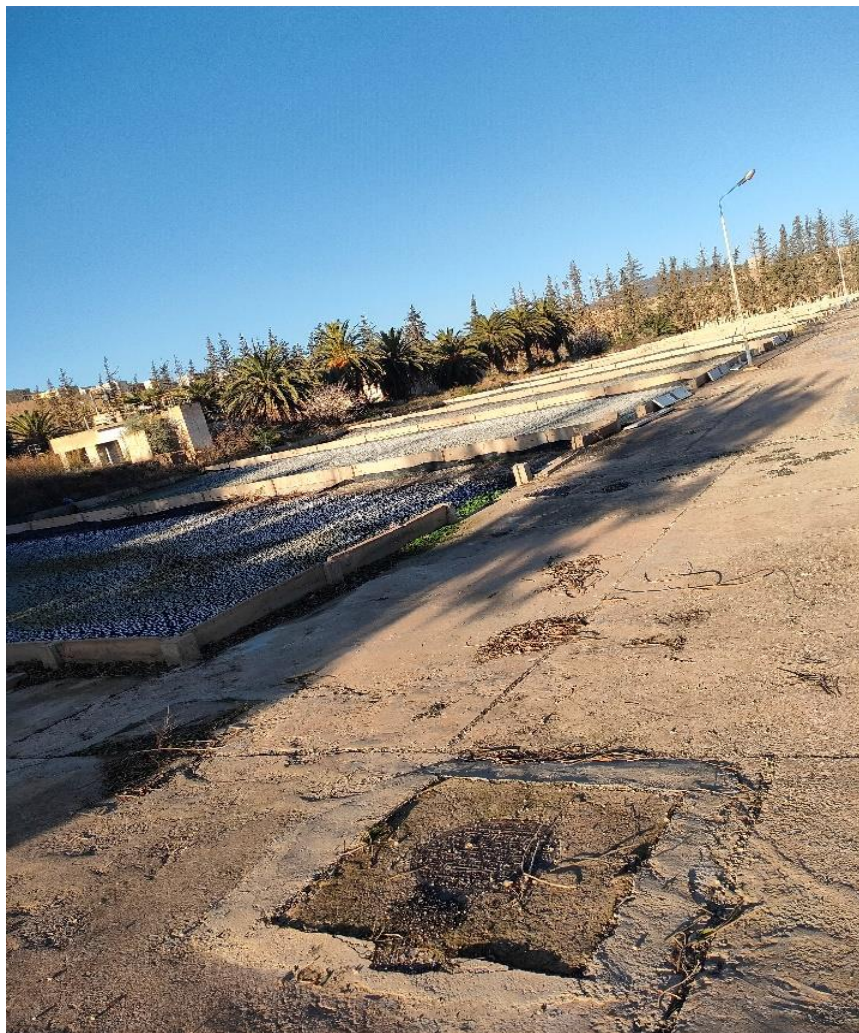
Fig. 13 : Les lits de séchages (Station de Saida : Janvier 2022)
