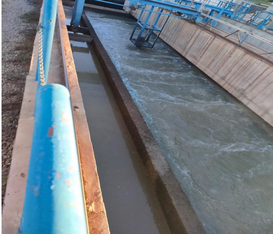
Fig. 06 : Déshuilage (Station de Saida : Janvier 2022).
