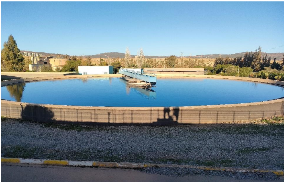
Fig. 08 : Décanteur secondaire (Station de Saida : Janvier 2022)
