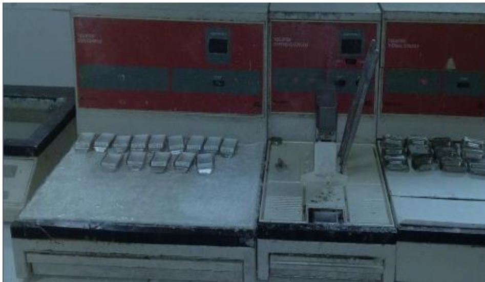
Figure 44 : La station d'enrobage utilisée
