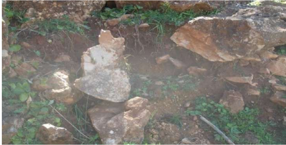
Photo 23 : Les dégâts causés par l'érosion hydrique au niveau du vieux Saïda. (Djeddi et Mahfoudi, 2015, Photo du 14/04/2015)
