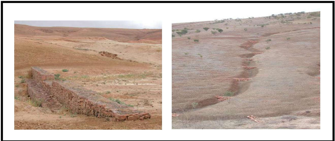
Photo 12 : Structure en gabion.
