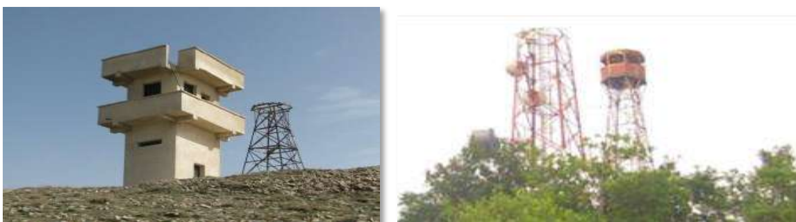
Figure 37 : les postes de vigie
