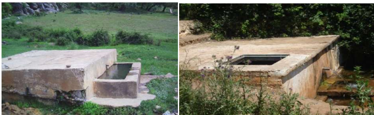
Figure 38 : construction et aménagements des points d'eau
